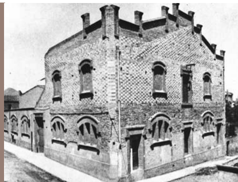
L'edifici de l'antic Sindicat Agrícola, en obres (1949)
